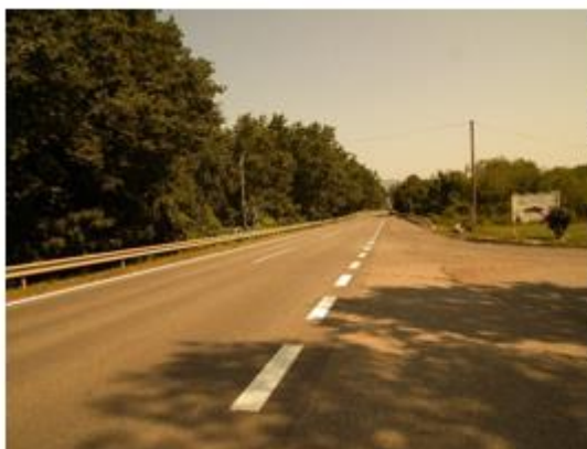
Km 745,800 – začiatok úseku
