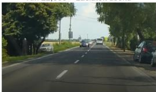
Km 22,300 – začiatok úseku
