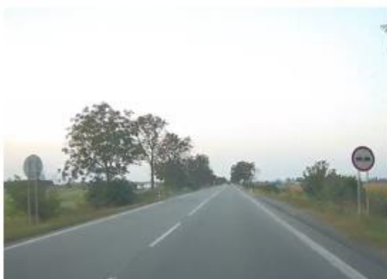
Km 5,510 – začiatok úseku
