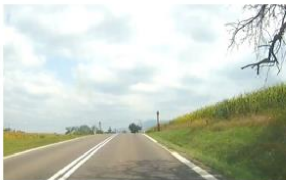
Km 13,600 – začiatok úseku
