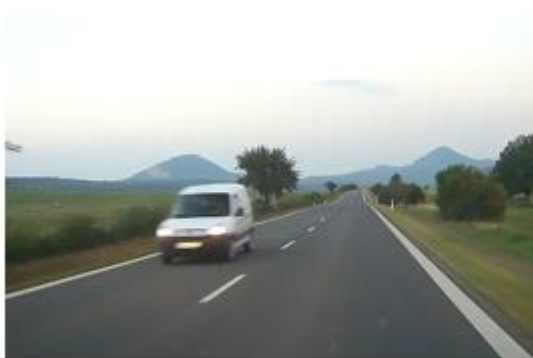
Km 68,300 – začiatok úseku
