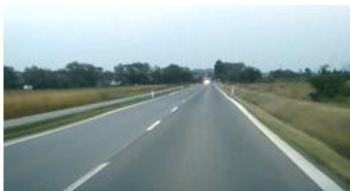
Km 59,200 – začiatok úseku
