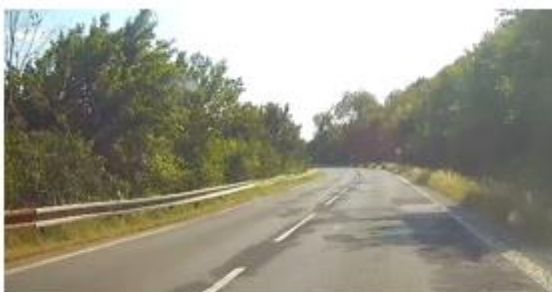
Km 86,780 – začiatok úseku
