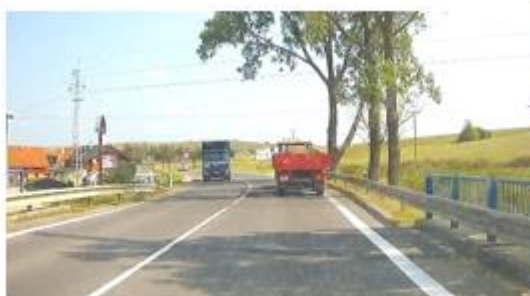
Km 96,615 – začiatok úseku
