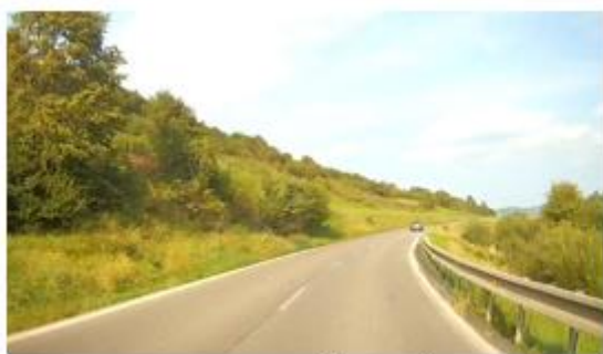
Km 8,190 – začiatok úseku
