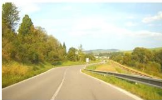
Km 8,690 – koniec úseku
