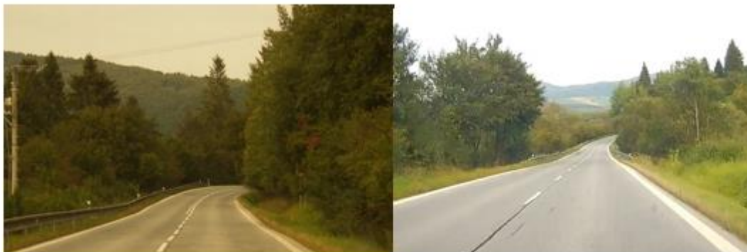
Km 27,500 – začiatok úseku
