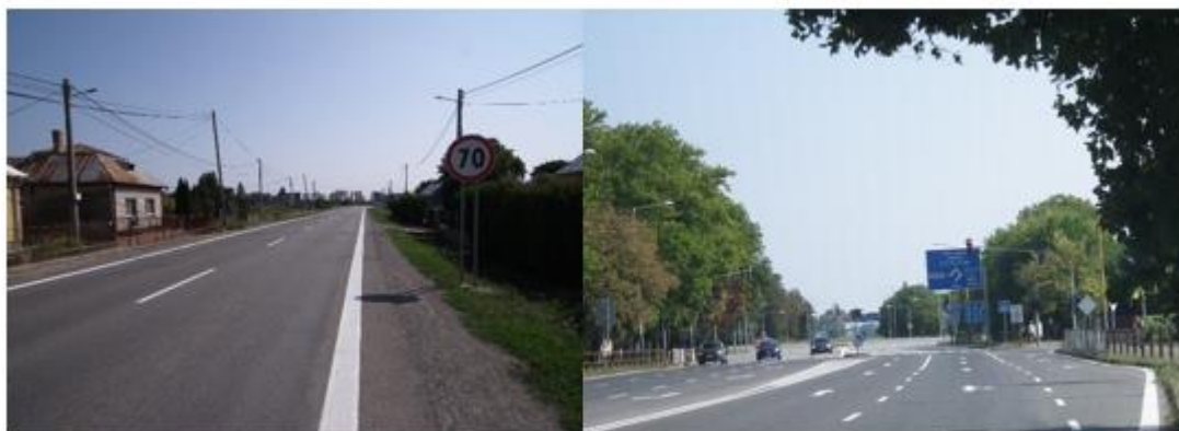
Km 758,500 – začiatok úseku
