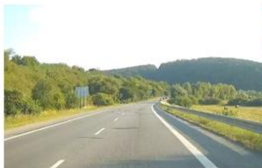
Km 74,500 – začiatok úseku
