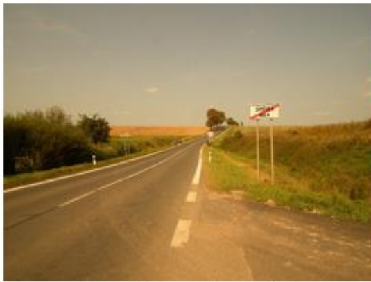
Km 1,100 – začiatok úseku
