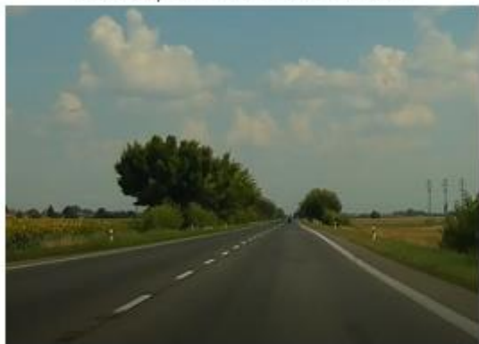
Km 14,800 – začiatok úseku
