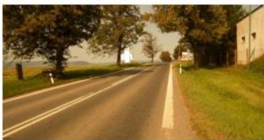
Km 0,700 – začiatok úseku
